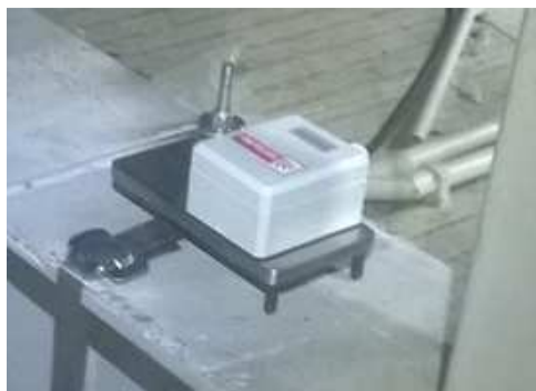
Rys. 6. Montaż czujnika inklinometrycznego na pasie dolnym dźwigara
